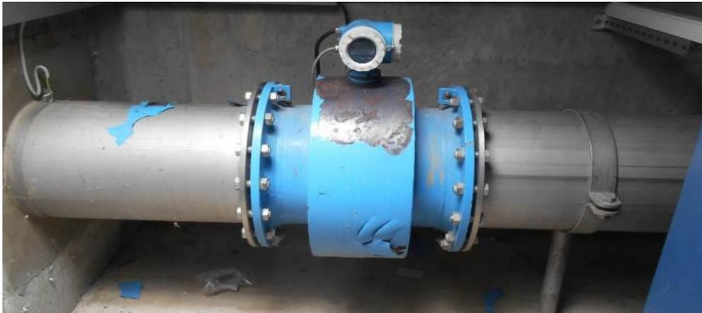
**Abbildung 6: Zulaufmengenmessung**
