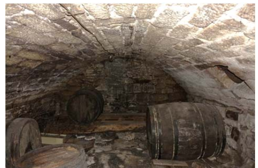
Abb. 5: Gewölbekeller unter Scheune
