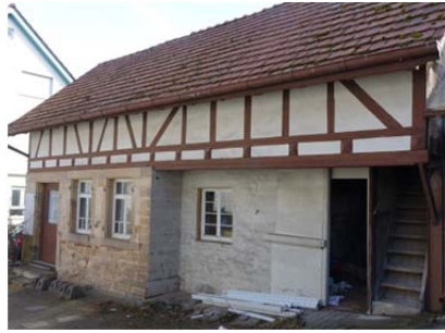
Abb. 6a: Schopf Ansicht Nordseite
